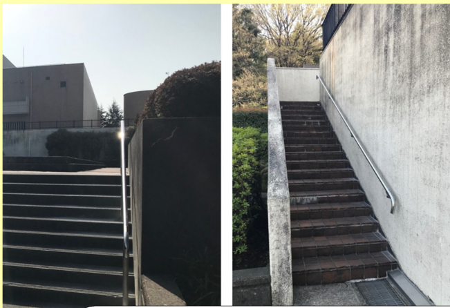
「憩いの広場」への動線の安全を確保すべく、中部浄化センターに手すりを設置してもらいました。
