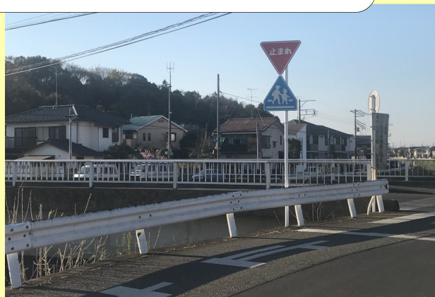
宮久保橋の欄干がぐらついて危険だったため、補修してもらいました。
