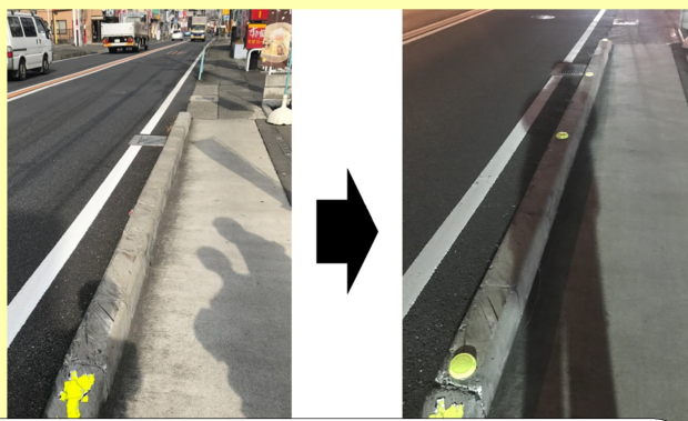
視界が悪い夜に自動車が境界ブロックを乗り越えて危険にならないよう、視認性を高める蛍光のマーカールを取り付けてもらいました。
